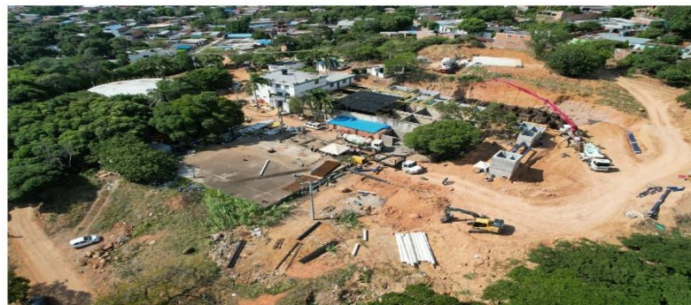
Fotografía No. 24. Panorámica lateral de las obras en ejecución.
