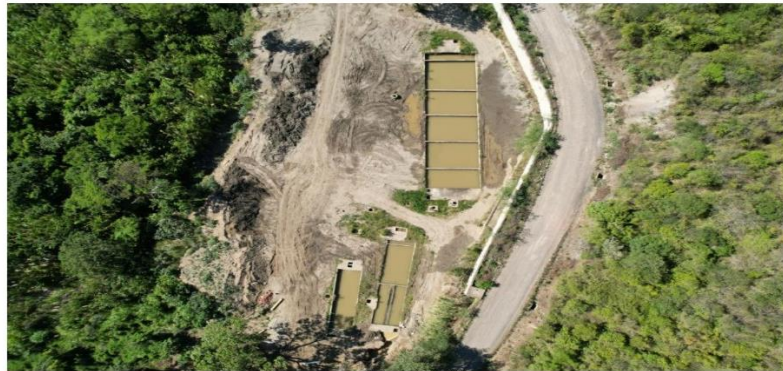
Fotografía No. 23 En las fotografías No. 21 fue tomada a la captación actual, las Fotografías No. 22 y 23, es el sistema de desarenación actual.
