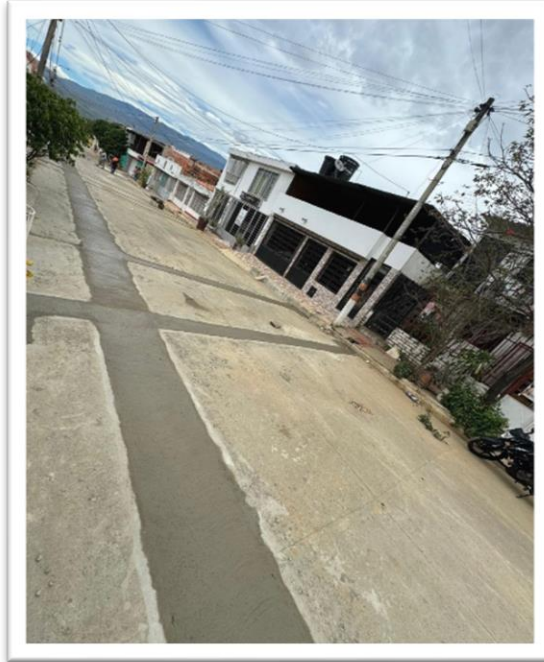
Ejecución Proyecto Barrio Los Trapiches – Reposición estructura del pavimento
